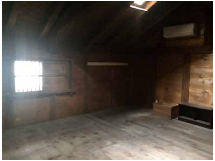
2階窓、板張りの壁
